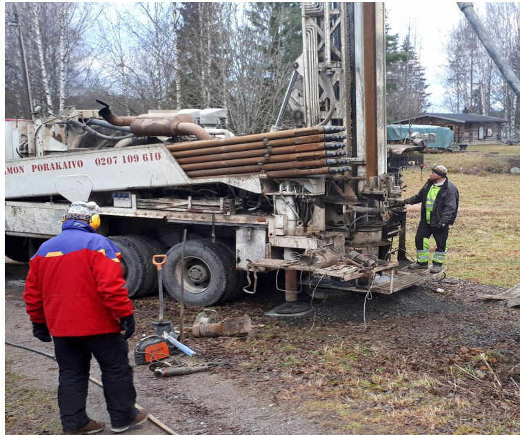
Kaivonporaus Pilpassa Kuva: Timo Tuppurainen
